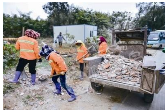
建筑垃圾清洁工
